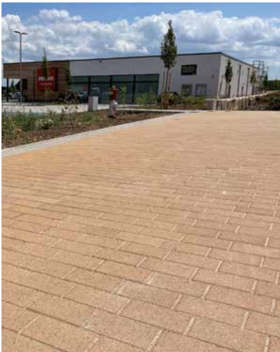
Auch einige Gehwege um den angrenzenden Supermarkt wurden mit dem wasserdurchlässigen Pflastersystem befestigt und erfüllen von der Gemeinde geforderte Werte für Regenwasserversickerung.
