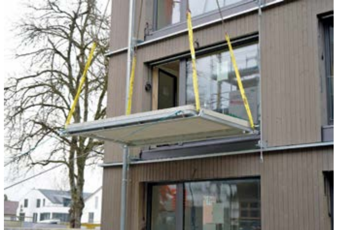
Einheben einer Balkonplatte.
