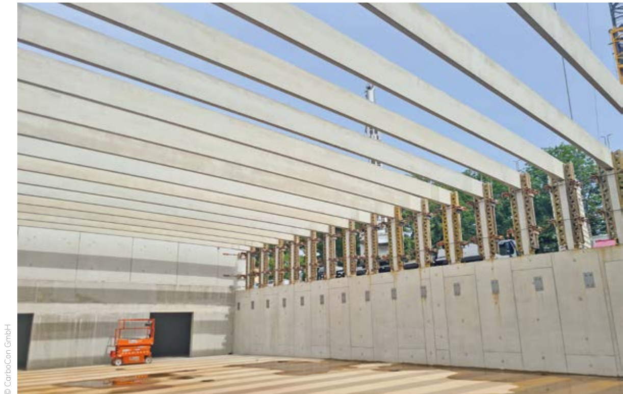
Turnhalle in Dresden: vorgespannte Carbonbetonbinder.
