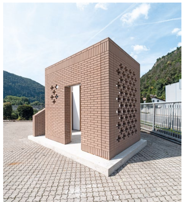
Das Mock-up zeigt, wie ein größeres Bauprojekt im heurigen Jahr umgesetzt werden wird.
