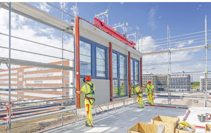
Die Außenwandelemente sind Hybridkonstruktionen, die inklusive Fenster und Sonnenschutz unter optimalen Bedingungen komplett vorgefertigt werden.
