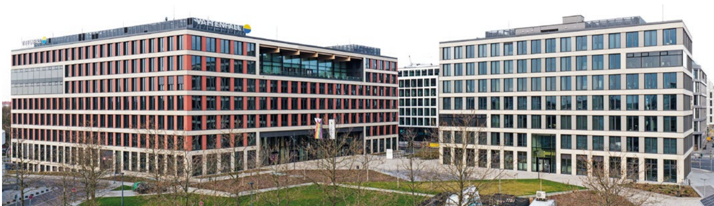
Bei der Holzhybrid-Konstruktion ergänzen sich die Materialien Holz und Stahlbeton hervorragend.
