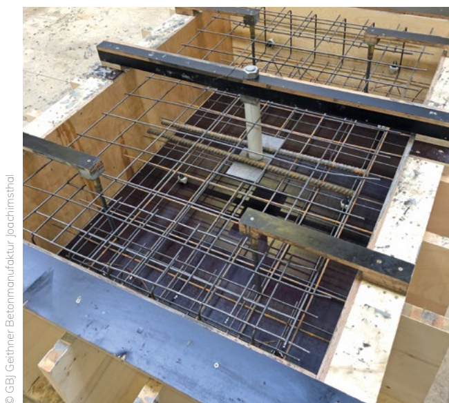
Flachstahllanker in der Schalung der Prüfplatte.
