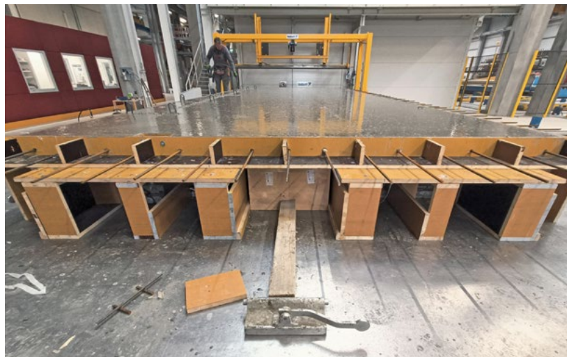
Betonierstation im Fertigstellungswerk.
