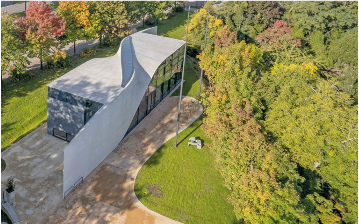
Der CUBE in Dresden ist das weltweit erste Gebäude, das vollständig aus carbonbewehrtem Beton errichtet wurde.
