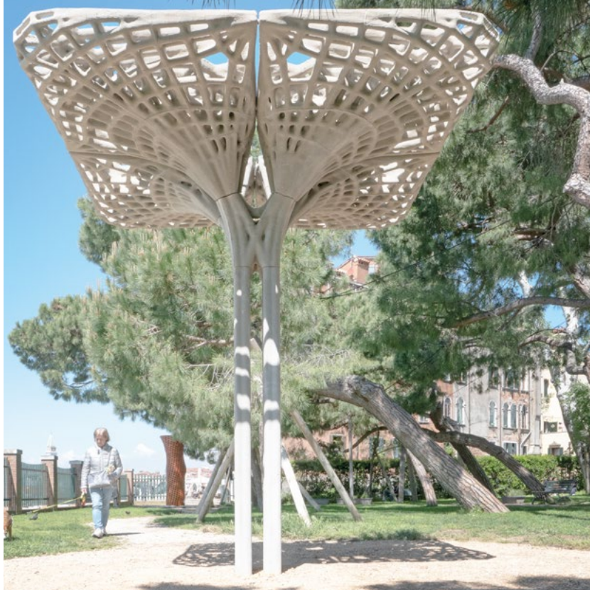
Der Marinaressa Coral Tree wurde für eine Ausstellung auf der Architekturbiennale 2023 in Venedig gebaut. Der Prototyp entstand im Rahmen eines Forschungsprojekts zur nachhaltigen Herstellung leichter Betonbauteile mittels abfallfreier Sandschalungen.
