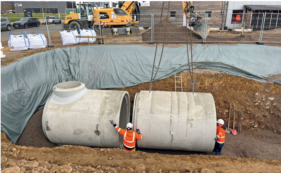
Montage der einzelnen Stahlbetonrohre.
