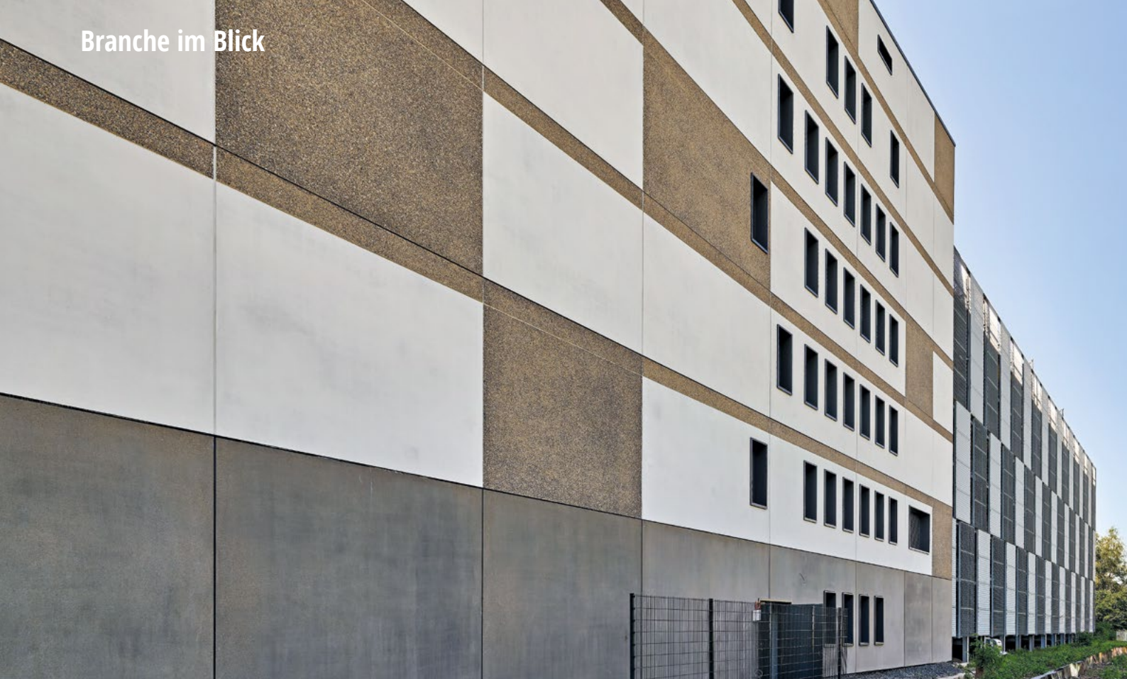
Rückseitige schallschützende Gebäudeansicht zur Bahnlinie hin.
