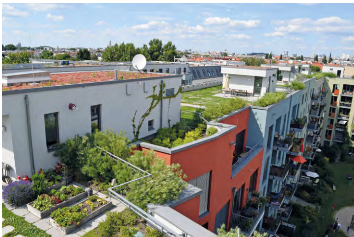
Gemeinschaftsdachgarten mit multifunktionaler Nutzung in Berlin. Regenwasser-speicher, Verdunstung, zusätzliche Nutzflächen für die Bewohnenden.
