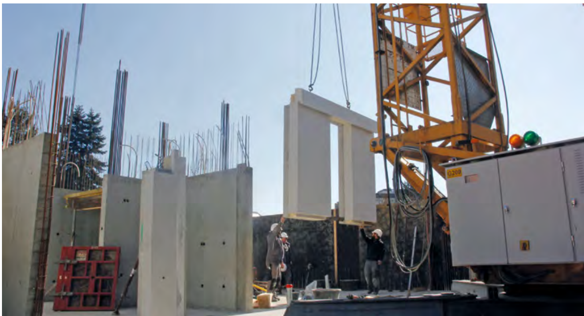
Setzen der Betonfertigteile für die Fassade.
