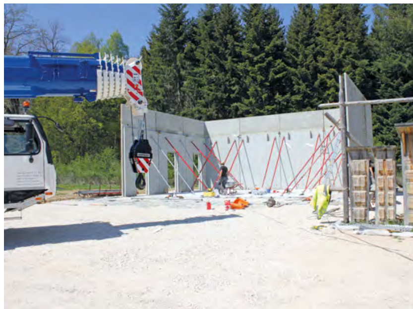
Die Zwischenlagerung der Betonbauteile erfolgte in Meßkirch direkt am Ort des Wiederaufbaus auf der grünen Wiese.
