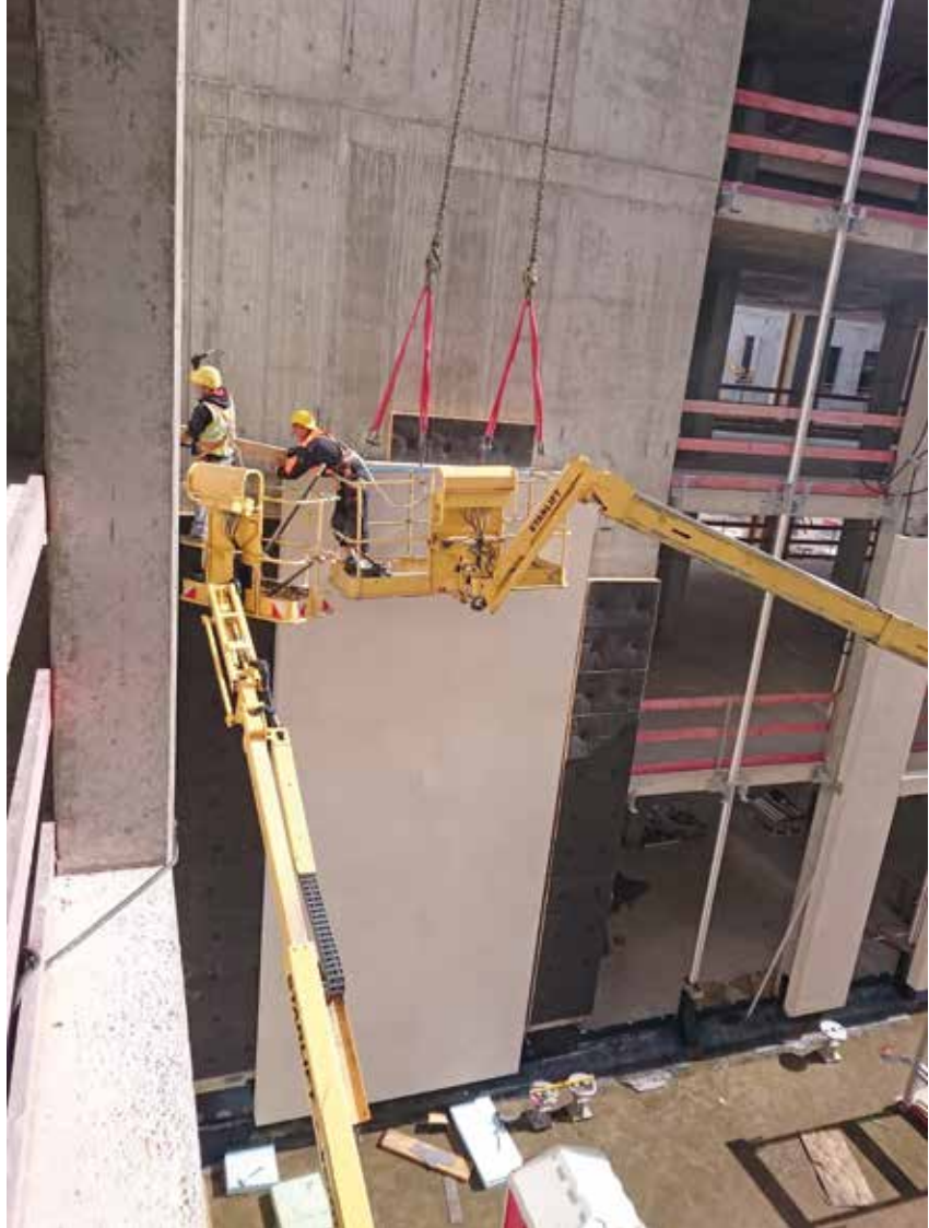
Präzisionsarbeit: Das Montieren von großformatigen Betonfassadenplatten
