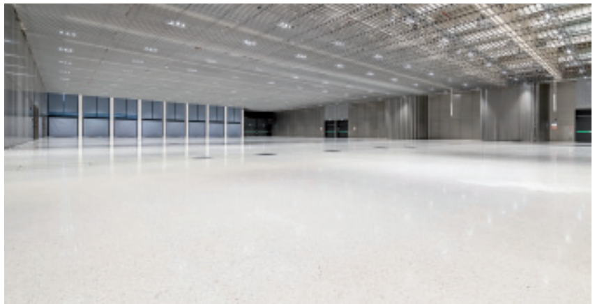
Optisches und betontechnisches Highlight: der fein geschliffene TERRAPLAN-Boden.
